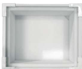
気泡状発泡 全面貼り
